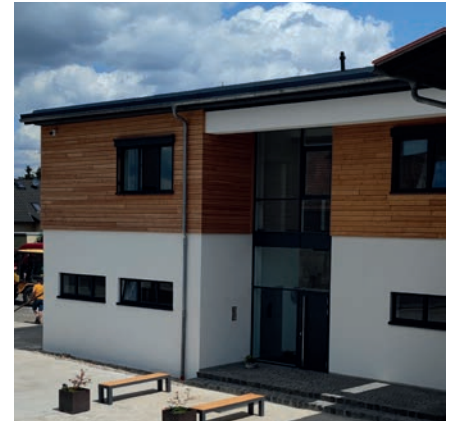
Außenansicht des neuen Bürogebäudes
